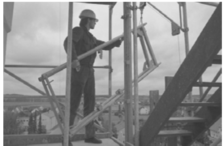
Het gebruik van een hijslier om het werk te verlichten is goed. Let op: bij het werken op hoogte moet adequate valbeveiliging worden gedragen/gebruikt, deze situatie is niet veilig.
